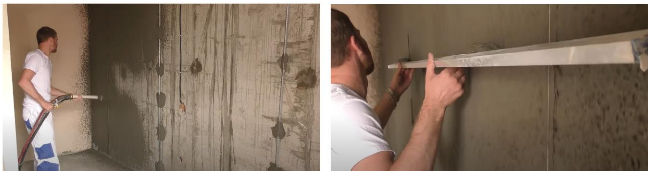
Рис. 23. Схема нанесения обрызга на поверхность и разравнивание правилами образовавшихся наплывов
