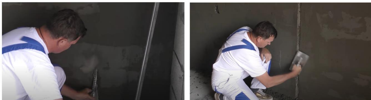
Рис. 25. Схема демонтажа маяков и заделки образовавшихся борозд
